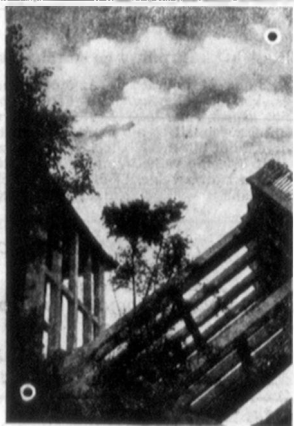
Egy épülő híd (Foto R. D. V)
